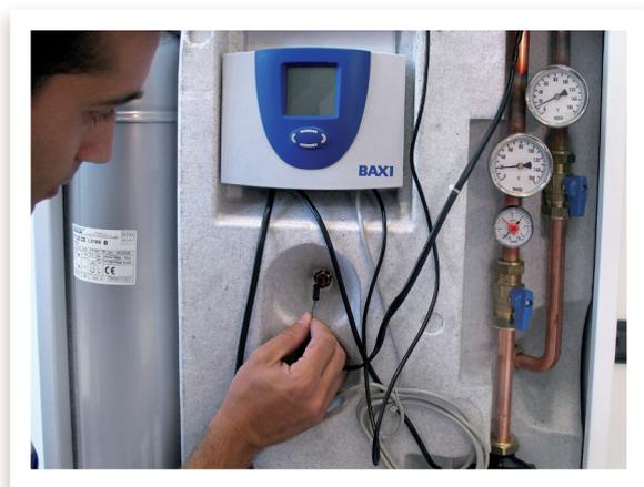
Procedere all'allacciamento elettrico della sonda bollitore e alimentare la centralina solare.
